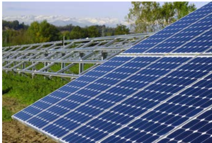
Construction en acier pour les panneaux photovoltaïques
