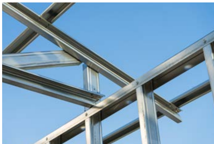
Construction légère en acier
