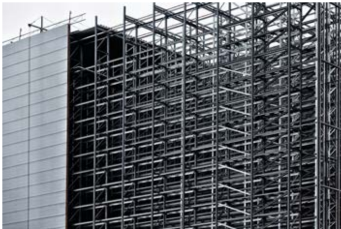
Construction de rayonnages hauts
